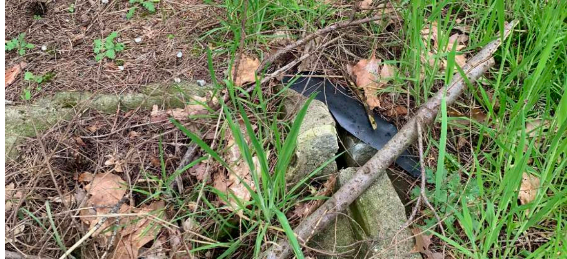
Figuur 17: Met name langs de randen van de noordoostelijk gelegen bak is het gebruik van PVC-folie duidelijk zichtbaar
