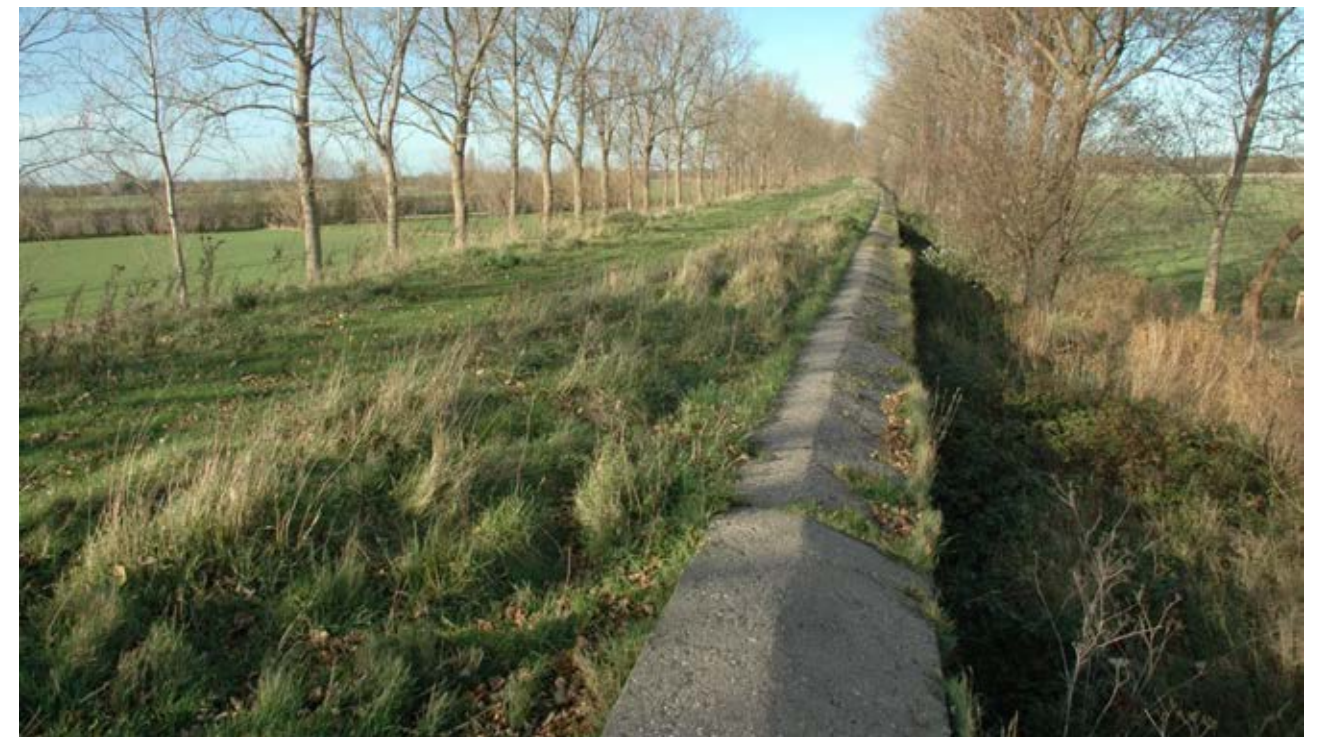
Afbeelding 4.29: De door de Duitsers aangelegde Atlantikwall loopt dwars door de gemeente Vlissingen, Walcheren vormde een belangrijke schakel daarin. Onder meer bij Vlissingen is een deel van de bunkers bewaard gebleven. Bij Ritthem ligt deze betonnen anti-tankmuur, die tegen de dijk is aangebouwd.
