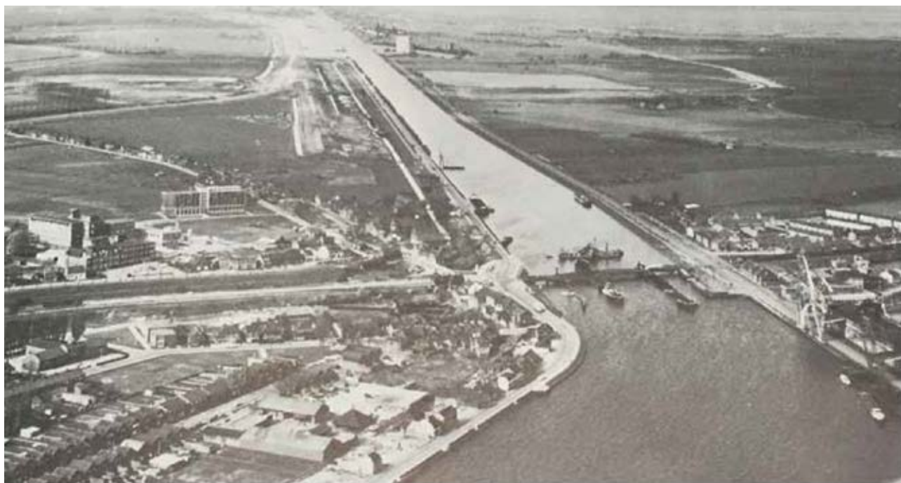
Afbeelding 5.33: De verbreding van het kanaal bij Sluiskil. In de jaren '60 moesten hiervoor een flink aantal huizen in het centrum van Sluiskil gesloopt worden. Op de achtergrond is de verbreding al te zien (richting Terneuzen)
